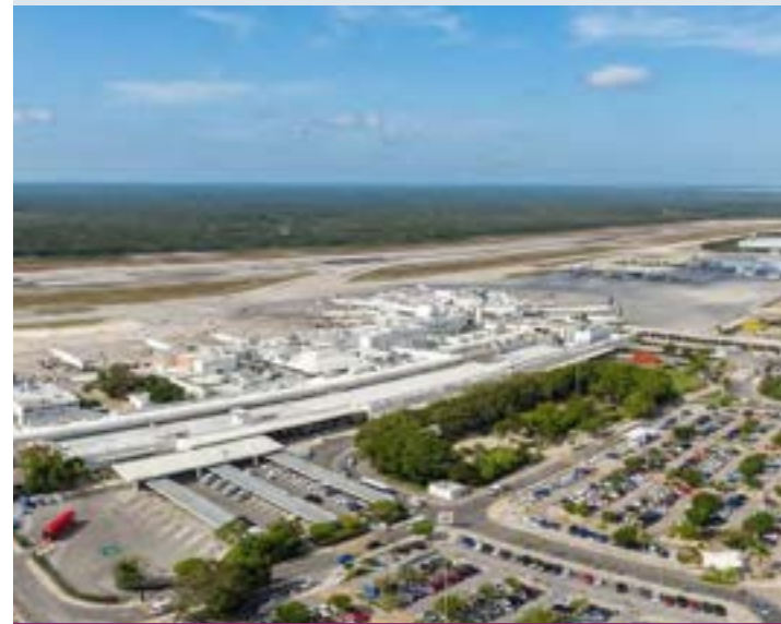
Aeropuerto Internacional de Cancún
