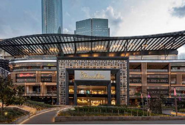
EL PALACIO DE HIERRO COYOACÁN
