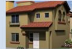
Casa Real Plus. Desde 122m2 (con terreno excedente)
