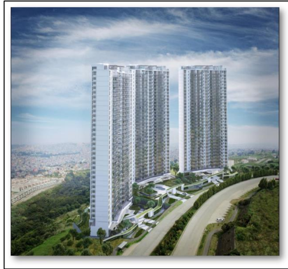
Vista General al Nororiente
